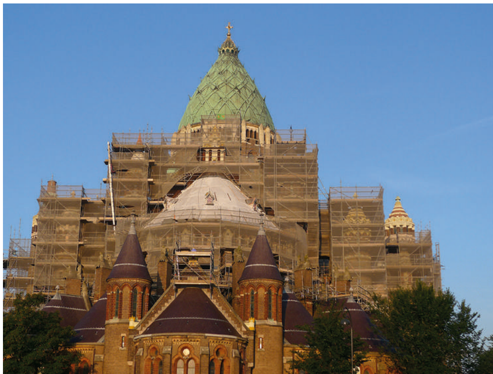
Het hoogkoor in de steigers.
