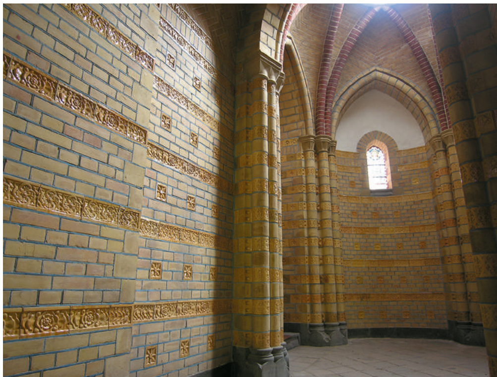
De doopkapel na restauratie gezien vanuit de kathedraal.
