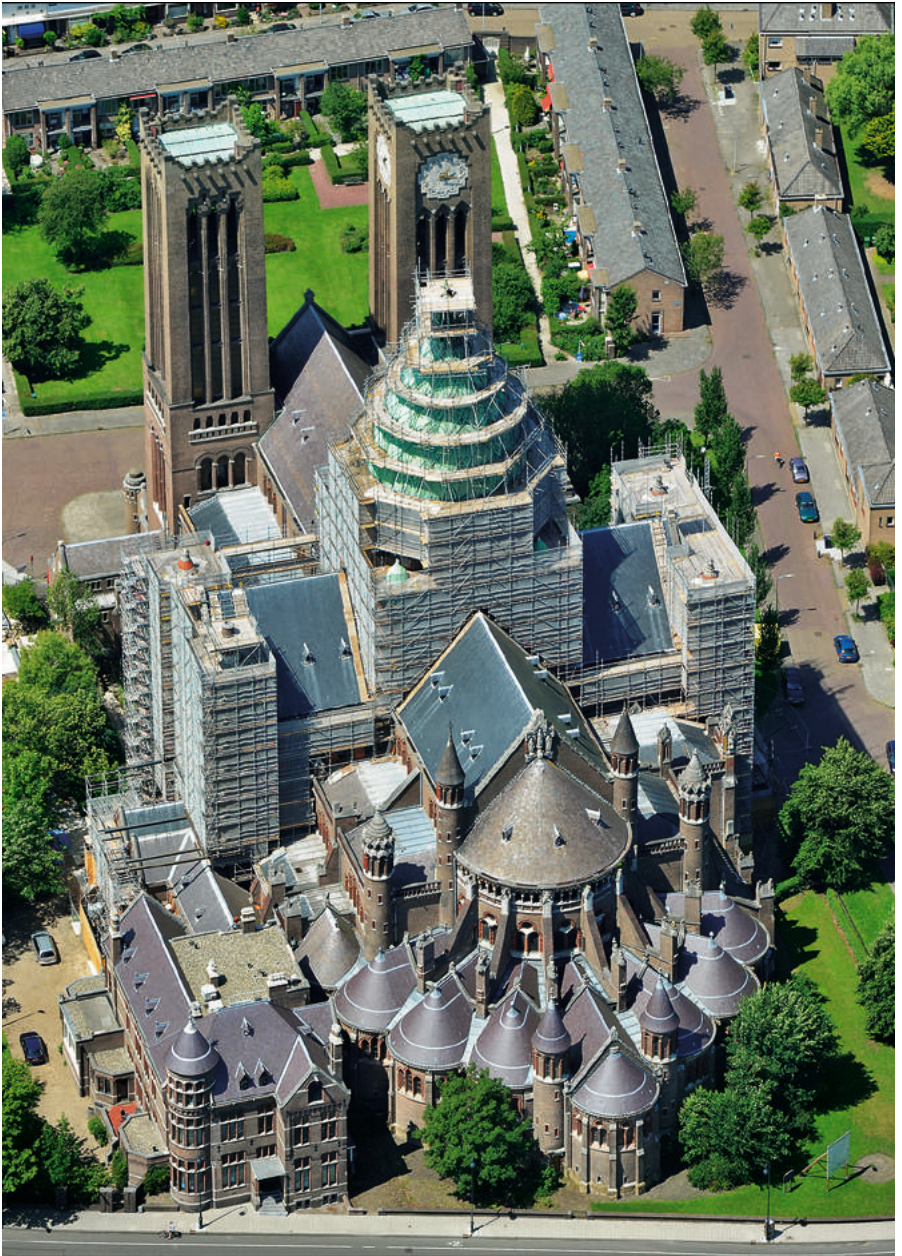
Transepten en koepel in de steigers.
