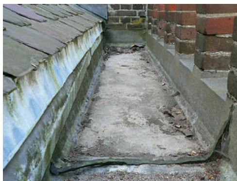
De lekkende goot – de naden waren soms met bitumen tevergeefs gedicht.
