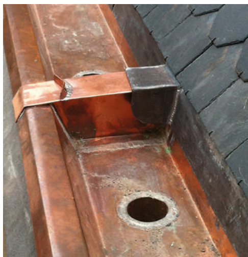
De lekkende goot – de naden waren soms met bitumen tevergeefs gedicht.
