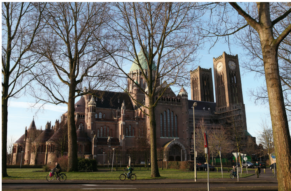
De kathedraal gezien vanaf de Westergracht met de steigers aan het middenschip. (Foto restauratiebedrijf Schakel en Schrale BV)
